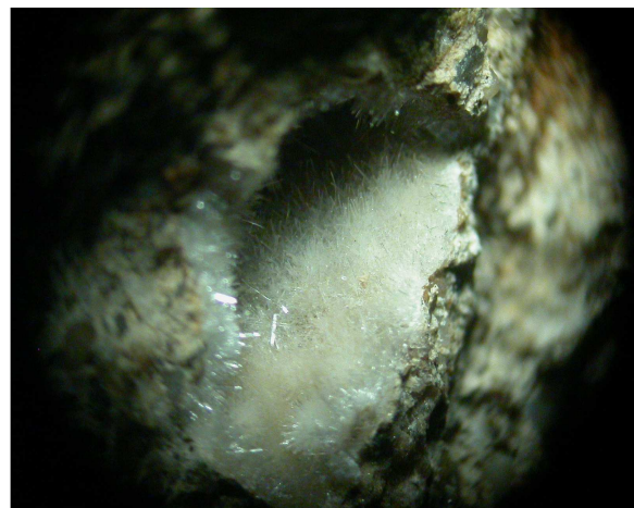
Photo 7 : Géode d'Ettringite en aiguilles dans béton Terril de Winterslag – Genk
